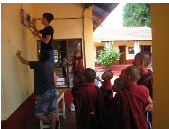
照片 5：志工協助修繕配電設備孩童好奇觀看
